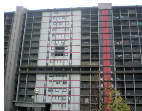
02 | Diga Bianca, fronte esterno. Le pareti opache sono rifinite con pannelli in lamiera di acciaio verniciato isolati con schiuma poliuretanic, camera d'aria e murature in blocchi di argilla espansa (foto: Giovanna Franco).
