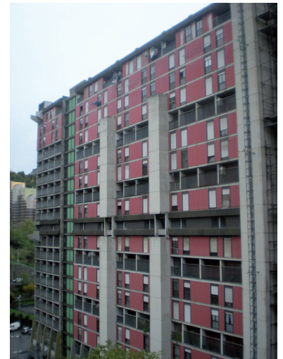
01 | Diga Rossa, fronte esterno. Sono evidenti i corridoi di distribuzione orizzontali, a quote diverse, cui era affidato, originariamente, anche il ruolo di collegamento tra i due versanti della valle. Interventi di riqualificazione effettuati nel tempo hanno interrotto tale percorso e accentuato una distribuzione verticale, con l'inserimento di nuovi corpi ascensore (foto: Giovanna Franco).
